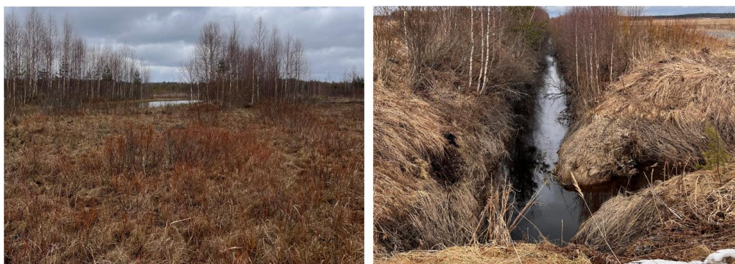
Kuva 7: Alueella sijaitseva imeytyskenttä (vas.) sekä viivytys- ja laskeutusallas ojan yhteyteen toteutettuna (oik.). Kuvat: Jaakko Leppinen.
