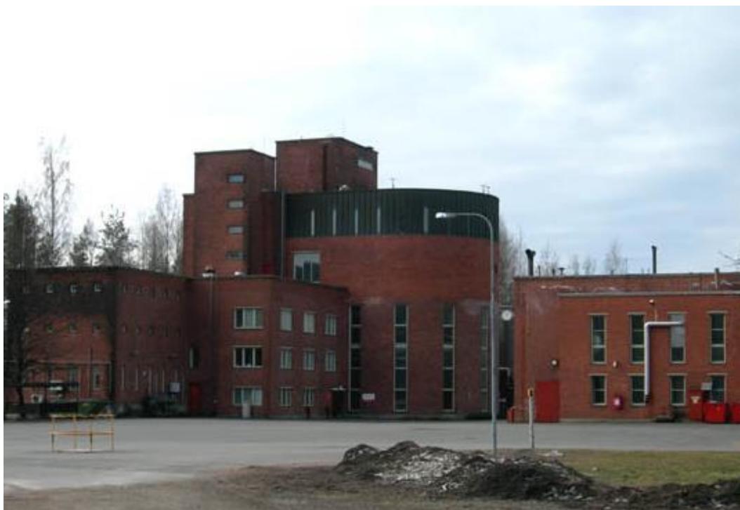
Kuva 47. Vuonna 1941 valmistunut, vanhempi tehdasrakennus Altian Koskenkorvan tehtaalla. Oikealla vanha voimalaitos. Tuija Mikkonen 2007.
