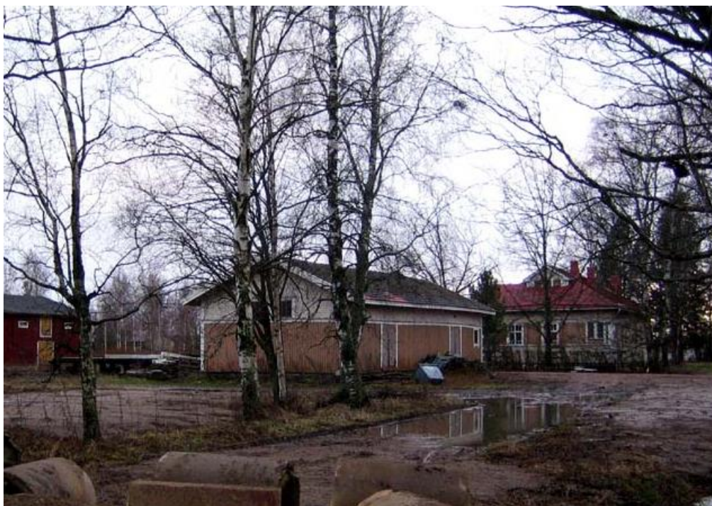
Kuva 50. Ilmajoen rautatieaseman tavaramakasiini ja asemarakennus. Kuva: MV/RHO Johanna Forsius 2006
