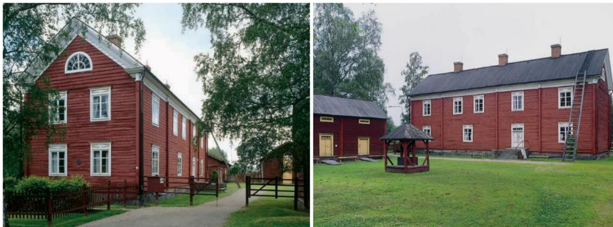
Kuva 52. Päärakennus ja kaivo. Kuva: MV/RHO Soile Tirilä 2000.
