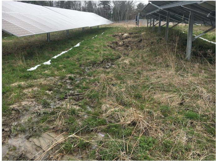
Eroosiohaittoja aurinkopaneelien välissä. (Kuva: https://www.stormwater.com/home/article/21148549/solar-and-stormwater )
