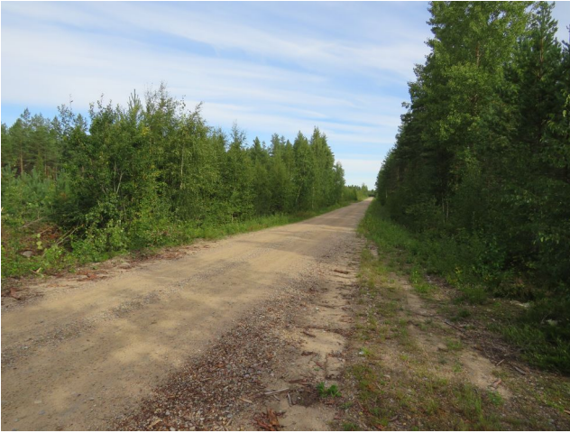
16. Kaapelilinjaus Korkiakankaantien varrella, etelään.
