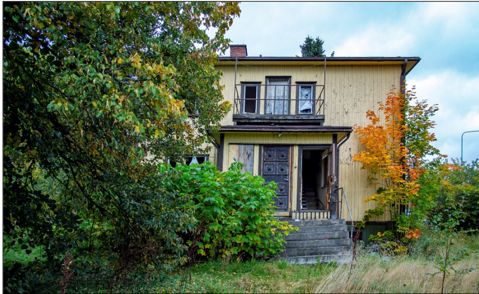
Rakennus tontilla 1022/3 on purkukunnossa. Perustuksetkin ovat haljenneet. Kuva: Eero Okkonen
