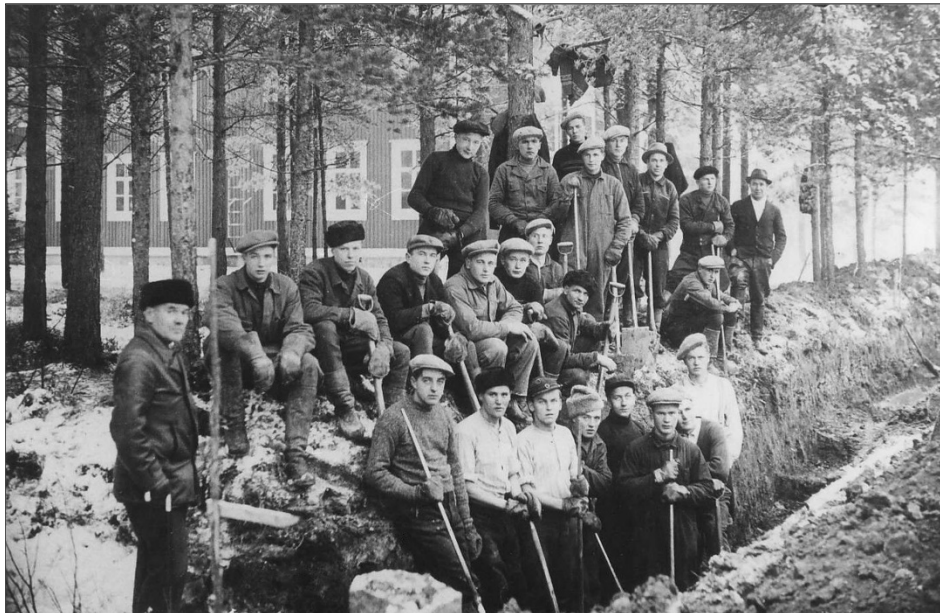
Yhteislyseon pihaan kaivettiin sodan alussa sirpalesuojia, kaivajina maamieskoulun oppilaita.
