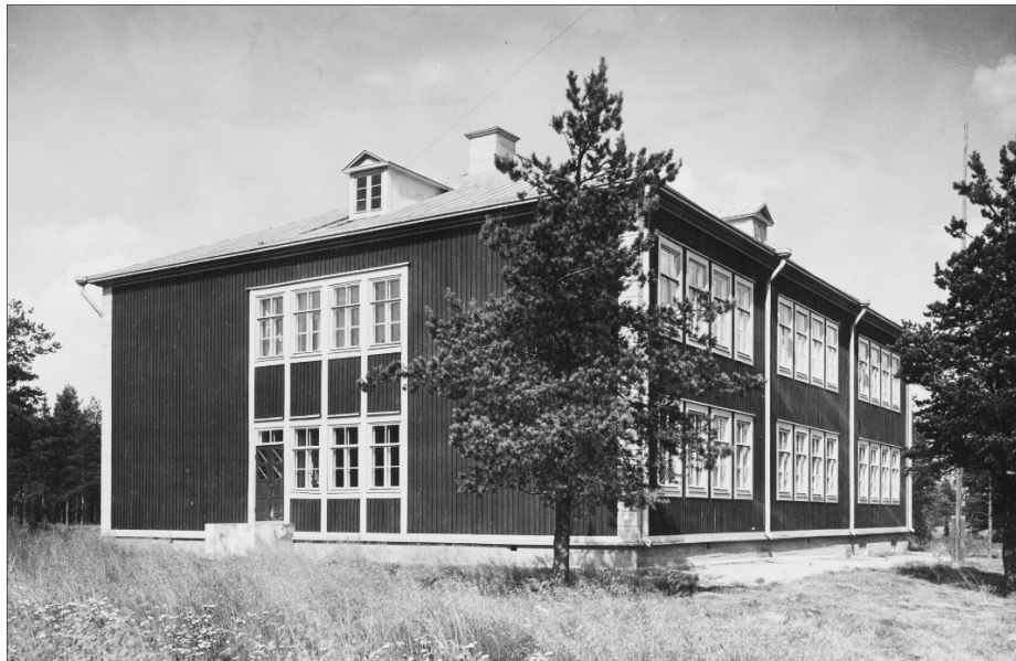
Yhteislyseon rakennus eteläpäädyistä nähtynä.
