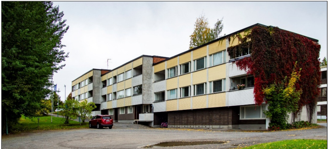
Tontilla 1001/4 sijaitsee 1966 rakennettu kerrostalo. Kuva Eero Okkonen.
