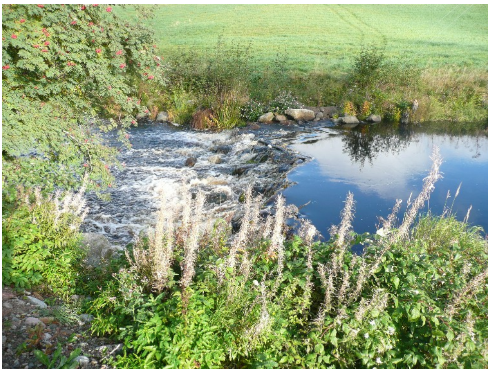
Kuva 7. Jyräsen kohteen kunnostettu pato kuvattuna joen etelärannalta.
