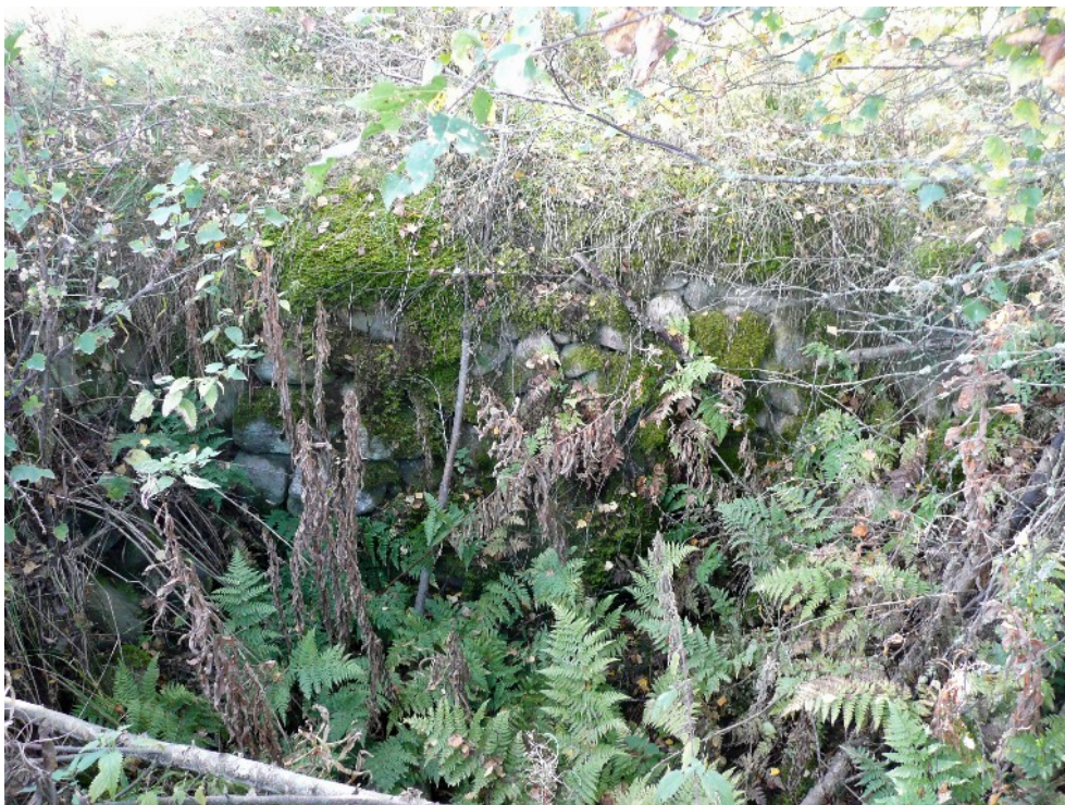
Kuva 13. Kellarikuopan eteläseinämän kylmämuurausta.
