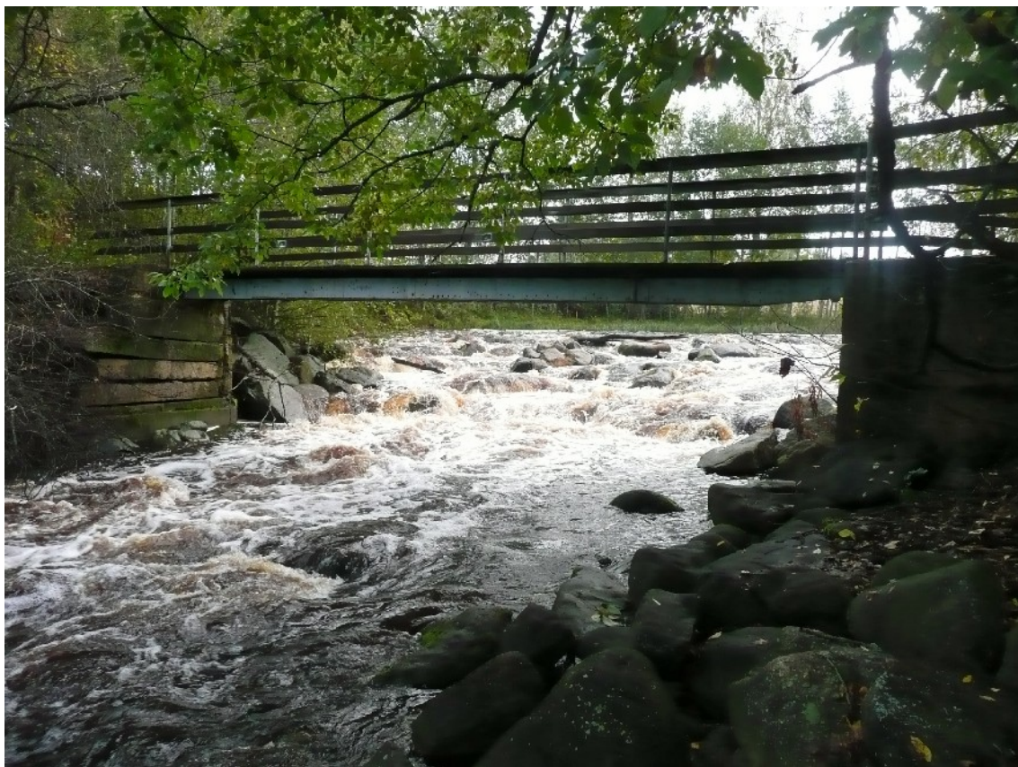
Kuva 8. Kunnostettu pato Ikkelänjoessa Koskelan kohteessa. Kuva lounaasta.
