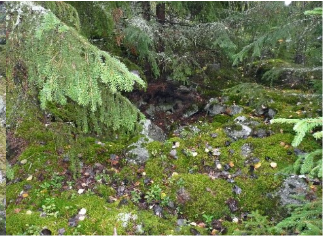
Kuva 20. Rakennuksen pohja 1 lännestä.
