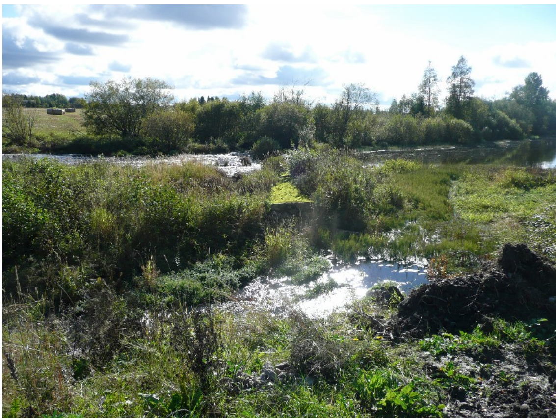
Kuva 14. Turjankosken pato kuvattuna pohjoisesta.
